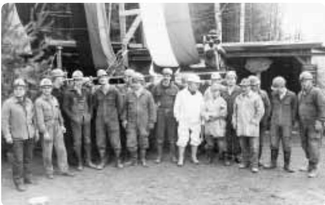
Das „Frischglück“-Team am Tag der offiziellen Einweihung im April 1985 mit dem Obersteiger des Fluss- und Schwespatbergwerks „Clara“ in Oberwolfach, Leopold Armbruster (im weißen Fahranzug). Als Fachaufsichtsperson hatte er wesentlichen Anteil an der erfolgreichen Realisierung des Besucherbergwerks. Er wurde zweites Ehrenmitglied des Vereins und verstarb wenige Monate danach.
